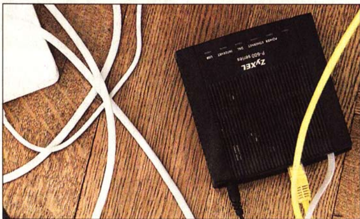
Offene Kabel, blanke Nerven
